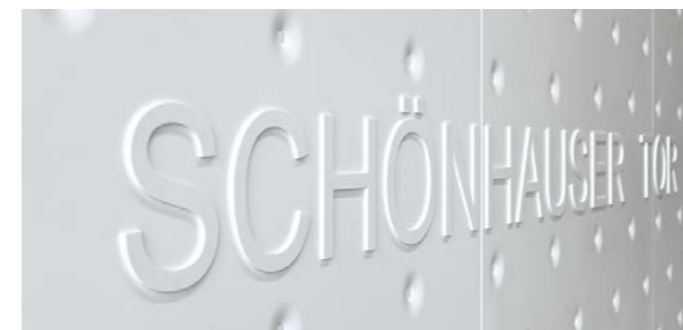
Außen effektiv bespielt, innen mit markantem Punkt-Design und mit CNC-Technik eingegräster Schrift.
