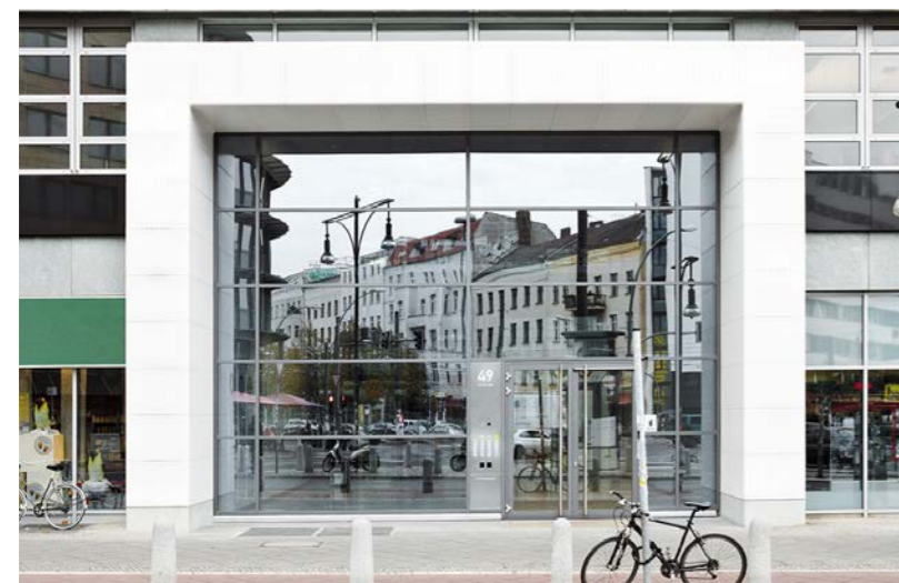
Tagsüber verbirgt sich die Lichttechnik unsichtbar und geschützt hinter der soliden HIMACS-Oberfläche.
